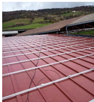
Cubierta Inclinada Metálica
